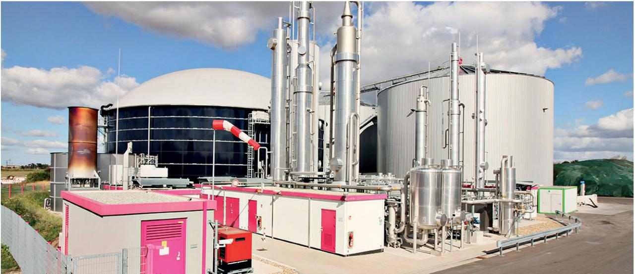
Grüner Kraftstoff aus Mist soll in einer Biomethananlage - hier eine Anlage des Investors revis bioenergy am Standort Gommern - im c-Port gewonnen werden. Foto: revis
